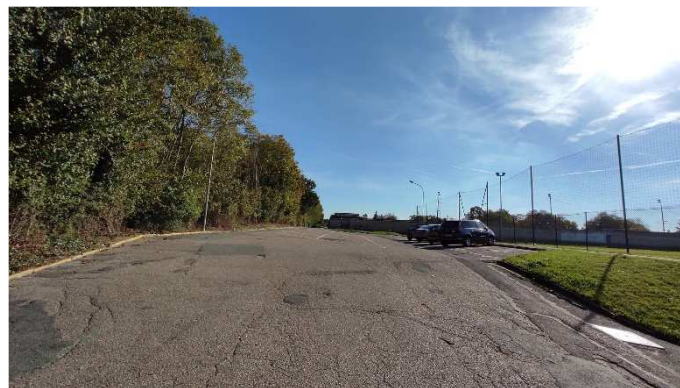
Stationnements du groupe scolaire le 27 octobre 2021, en bordure du bois de la Petite Garenne
