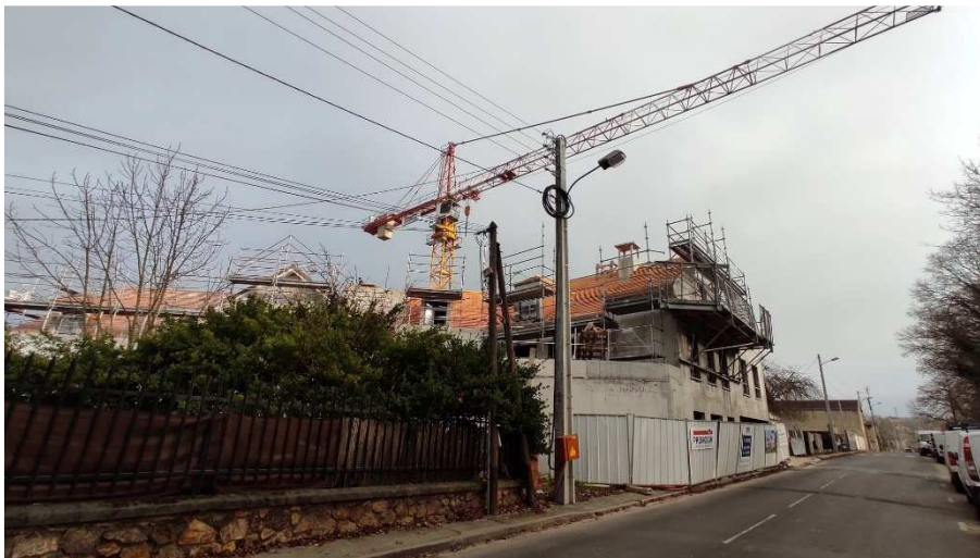
Constructions en cours rue Camille Plaquet, le 23 décembre 2021
